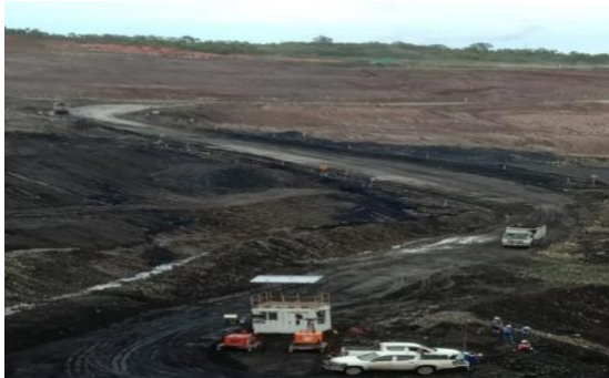
Gambar 4. Kondisi Jalan Angkut
