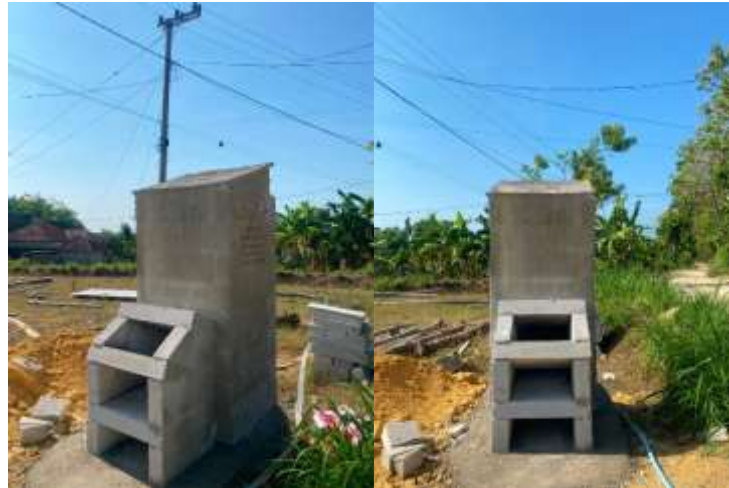
Gambar 1. Hasil pembuatan Rocket Stove sebagai alat pembakaran sampah minim asap
